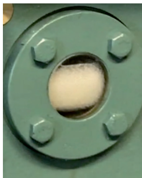
Opschuimend carter t.g.v. te sterke daling zuigdruk
